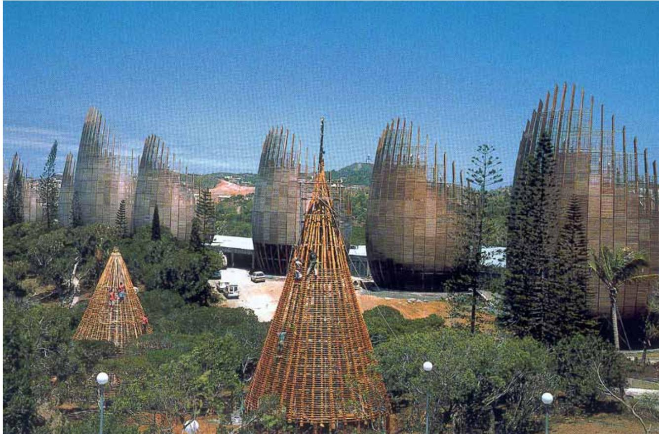
***Typologie systèmes constructifs: Ossature - remplissage***
