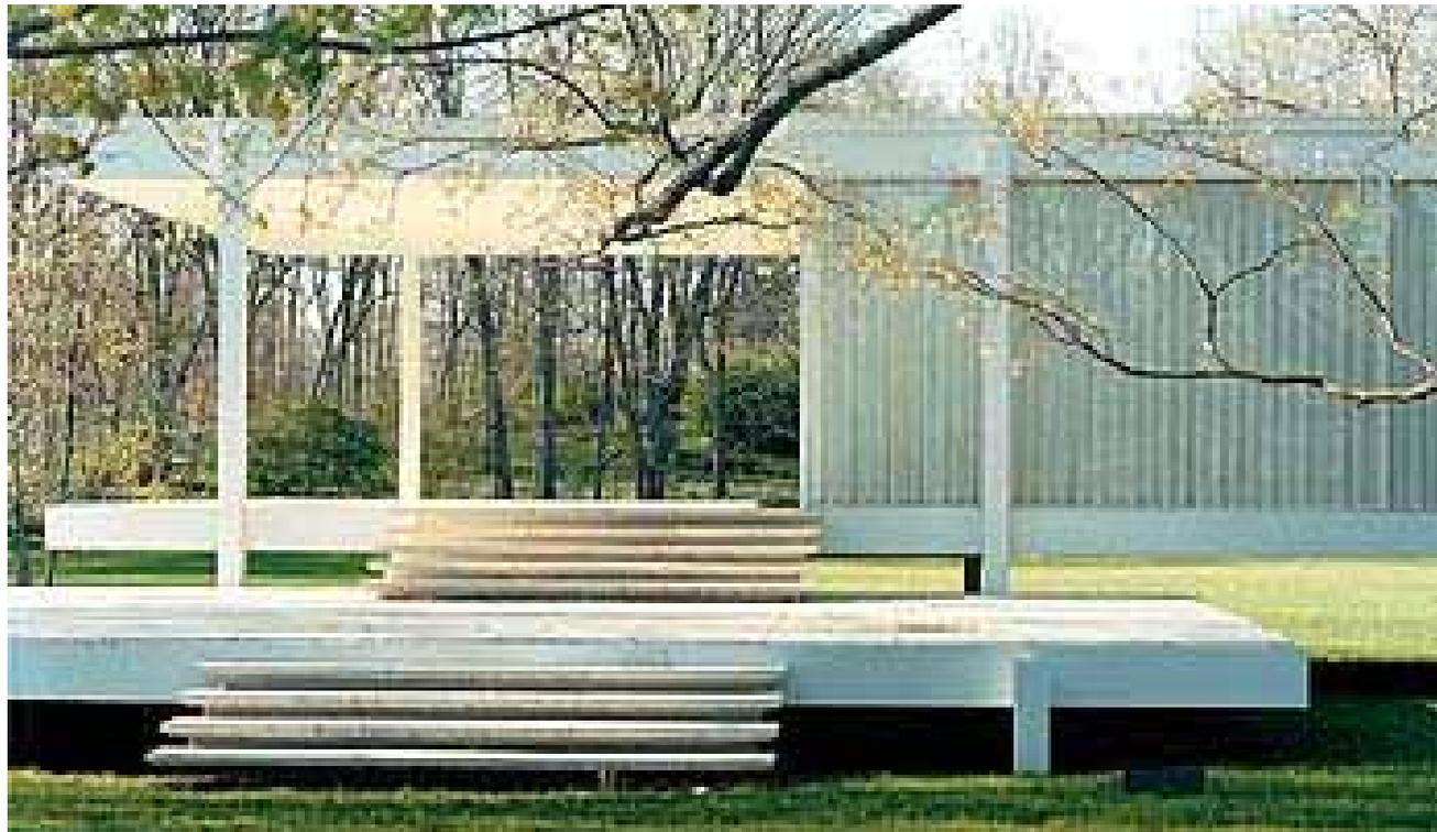
***Typologie systèmes constructifs: Ossature - remplissage***
