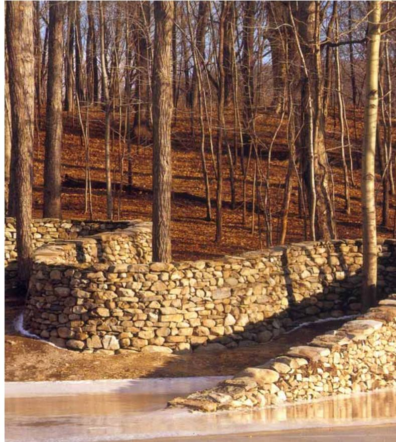
*Typologie systèmes constructifs: Blocs autostables*
