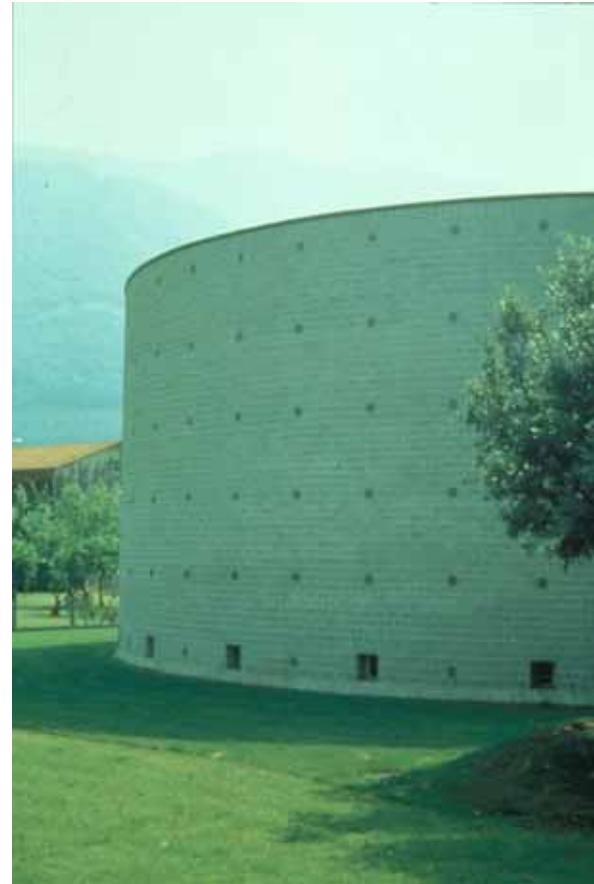
***Typologie systèmes constructifs: Blocs autostables***
