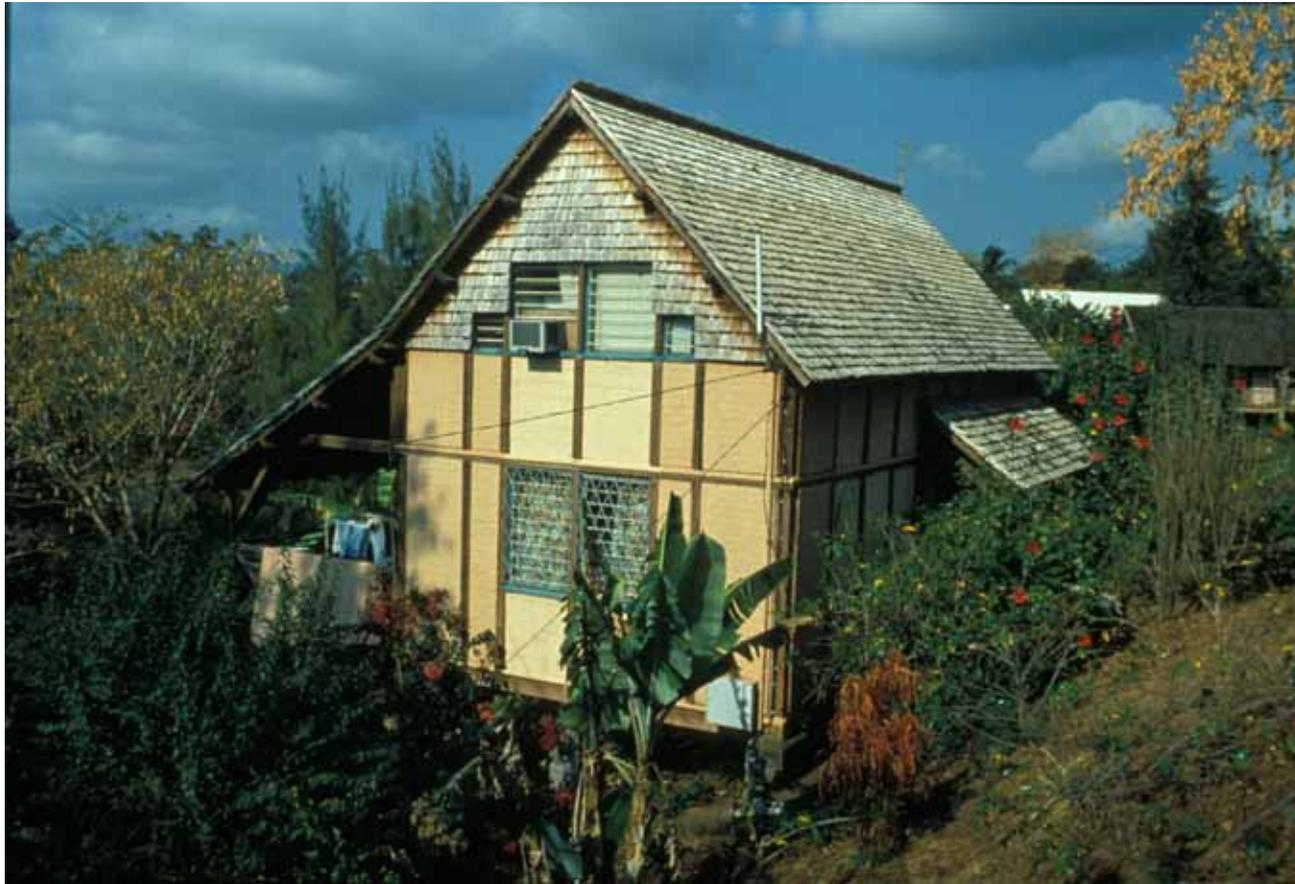
***Typologie systèmes constructifs: Ossature - remplissage***
