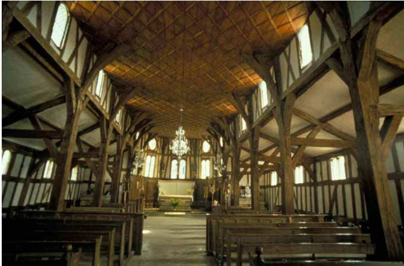
*Typologie systèmes constructifs: Ossature - remplissage*
